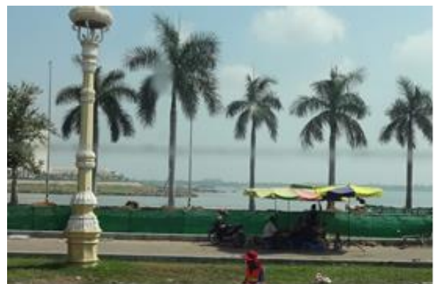
トンレサップ川（手前）とメコン川の合流点・護岸の工事
