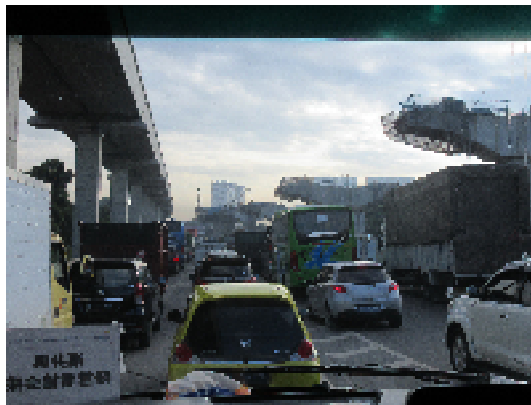
左は高架鉄道、右は高速道路の高架工事で 3 車線しか使えない状況に
