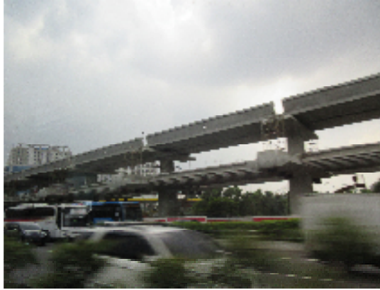
東に延びる高架鉄道が建設中
